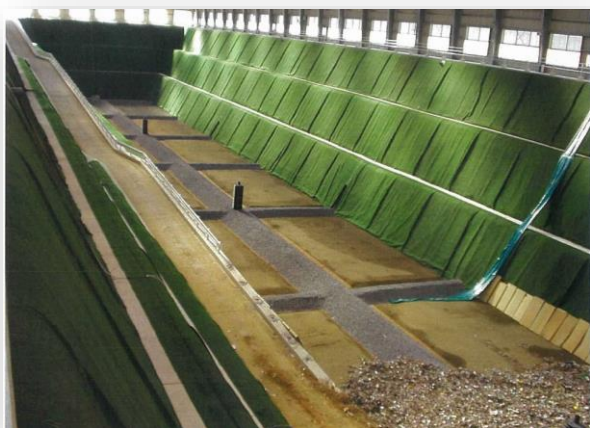
貯留施設内観
