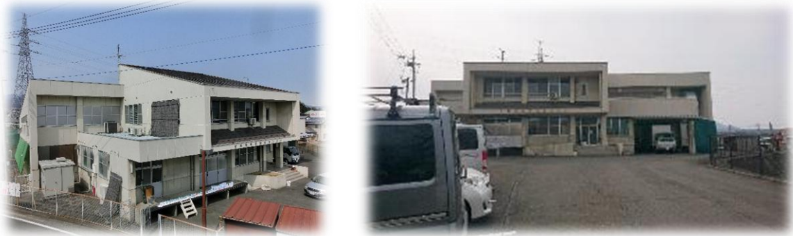
図 1-1 現給食センターの外観（左：南側道路より、右：東側出入口より）
