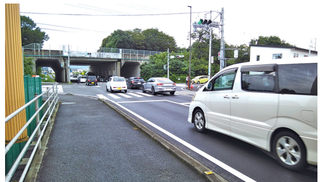
混雑する関越道カルバート部と交差点
