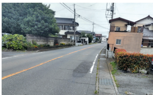
経年劣化による振動に対策を（町道の補修箇所）
