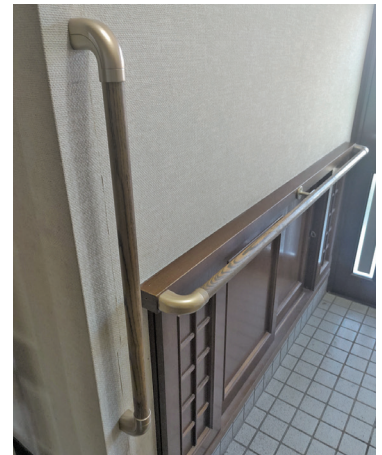
介護保険住宅改修工事で 取り付けた手すり
