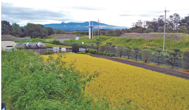
都市公園に向け工事中の天神東公園
