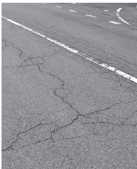
ひび割れが進む道路。シール材注入工法の修繕で長寿命化がはかれる。
