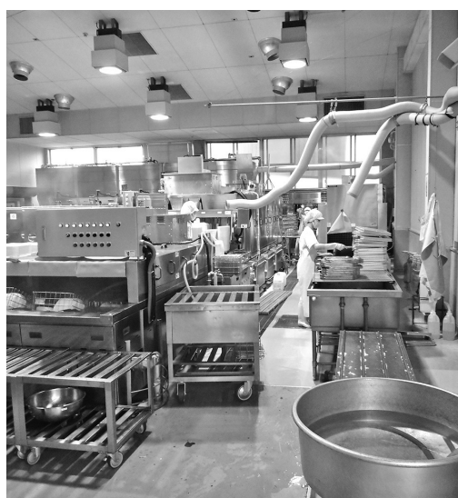
老朽化が進み、建て替えの検討も進んでいる (学校給食センター)
