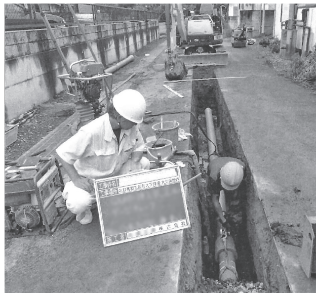
更新が進む老朽石綿管
