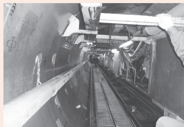
掘削中の併設水路
