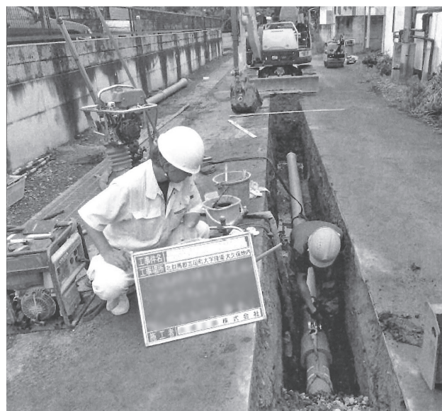
更新が進む老朽石綿管
