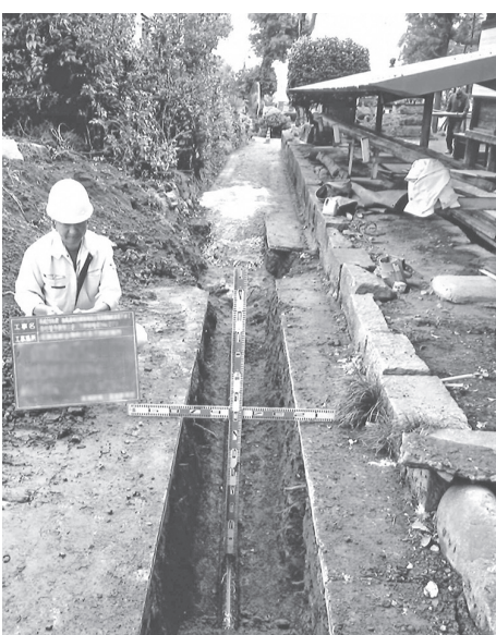
工事が進む老朽管布設替（下野田地区）
