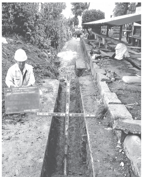
工事が進む老朽管布設替（下野田地区）
