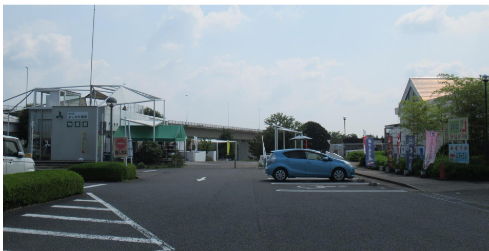
写真6 物産館と温泉施設の間の「増築予定箇所」
